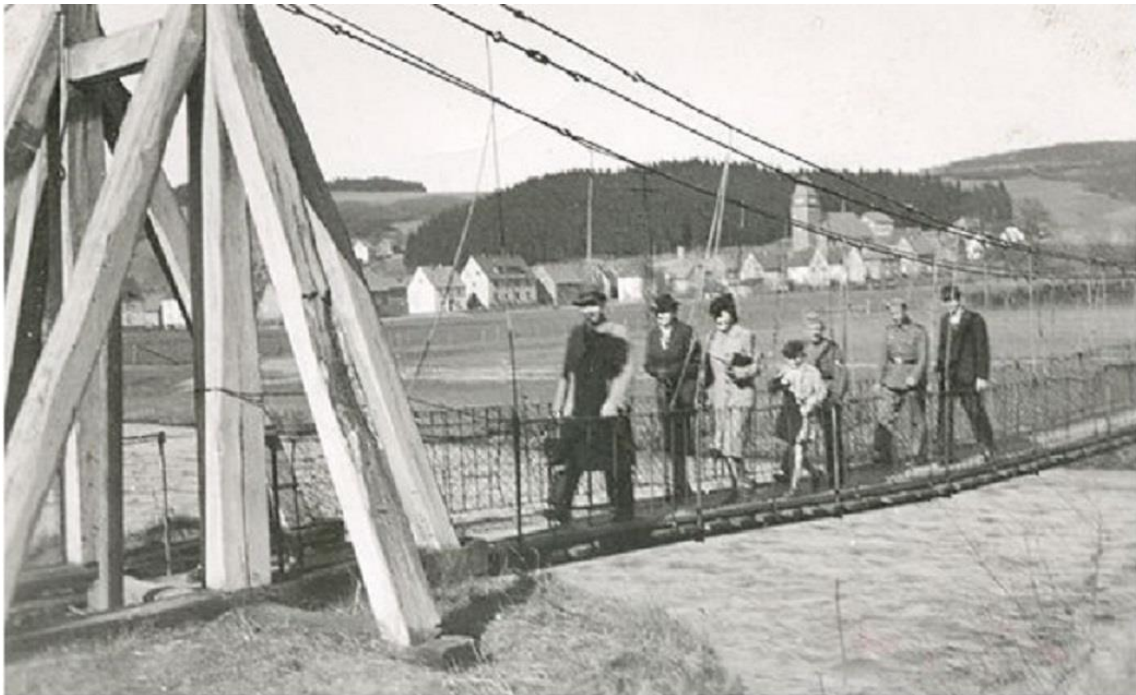
Foto aus dem Jahr 1940. In den 1970er Jahren Abgang der Brücke durch Hochwasser. Fotograf : Helmut Lehnen
